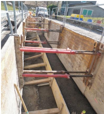
Bétonnage des collecteurs
