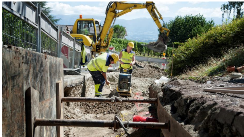
Remblayage de la fouille commune : collecteurs, eau, gaz et EP
