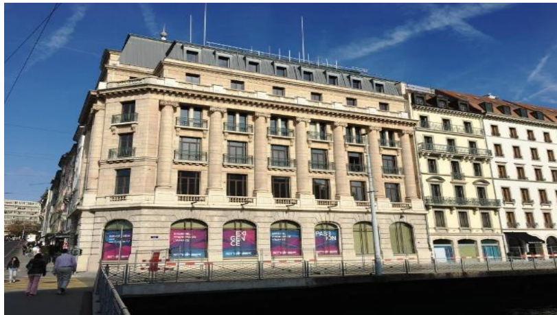
Après les travaux
