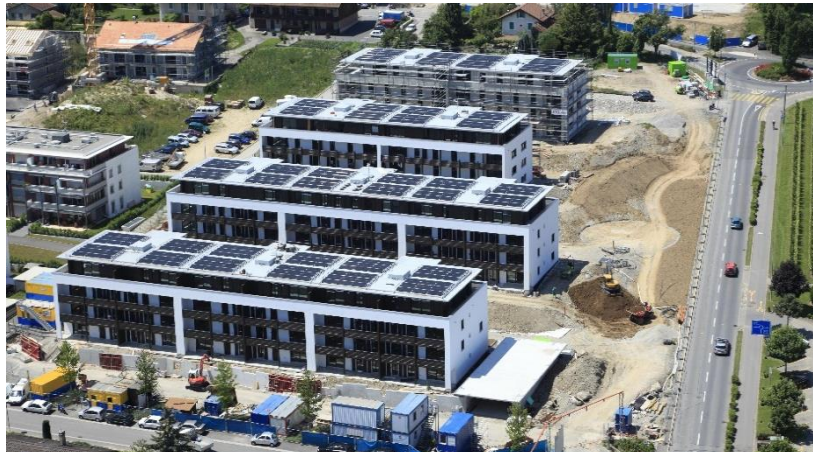
Après les travaux
