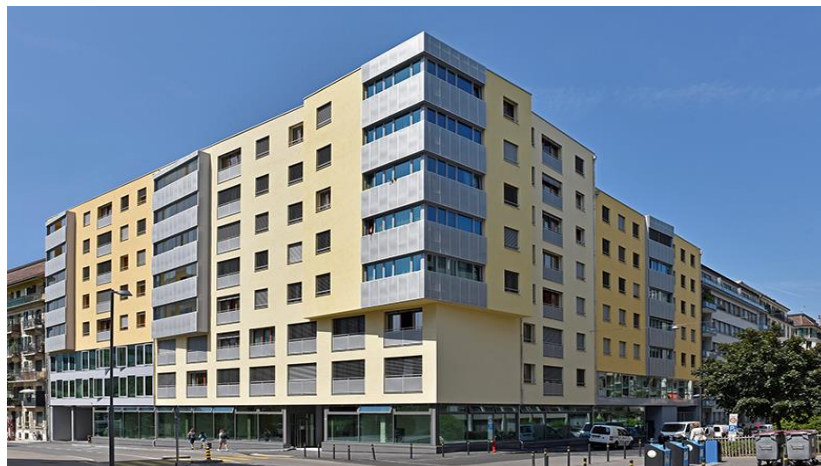
Après les travaux
