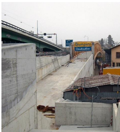
Accès à la passerelle
