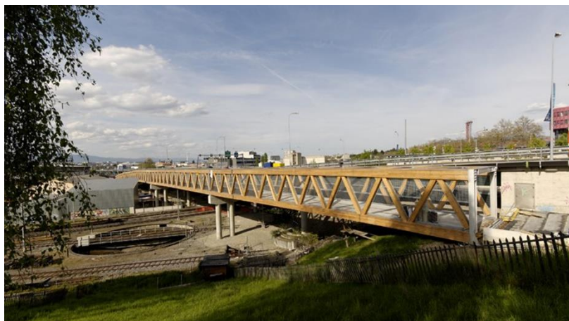
Passerelle en bois sur voies CFF
