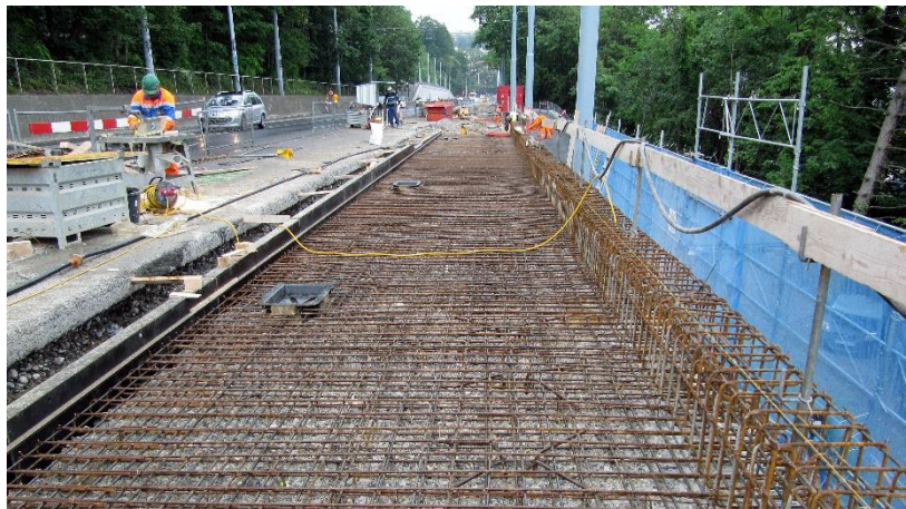
Pose des aciers d'armature
