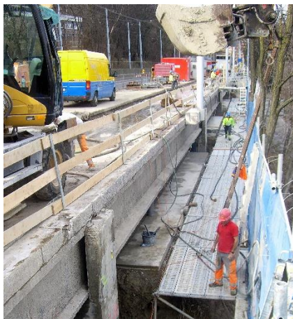
Travaux préparatoires avant la construction
