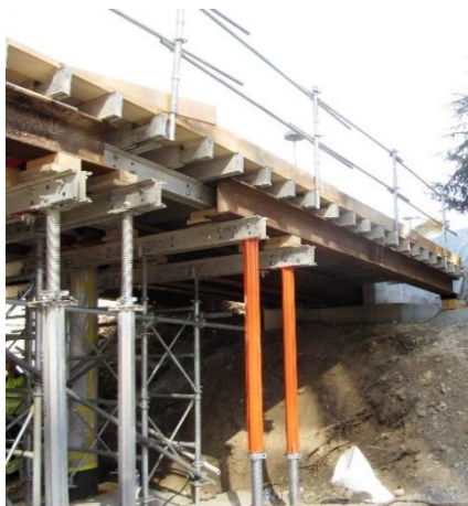
Pose du cintre
