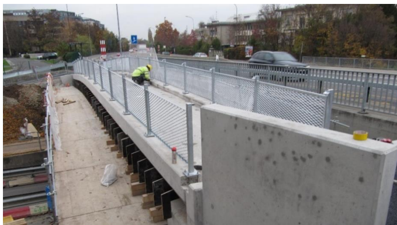
Travaux de finition
