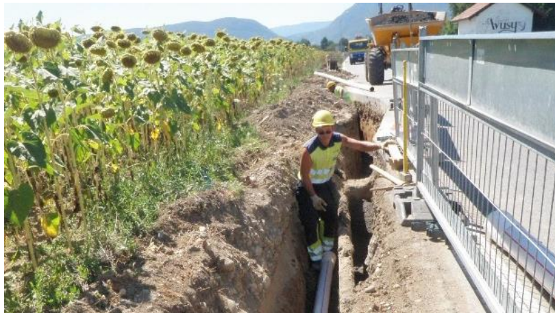
Pose des tubes
