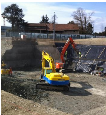
Terrassement et forages pour clouage de la paroi
