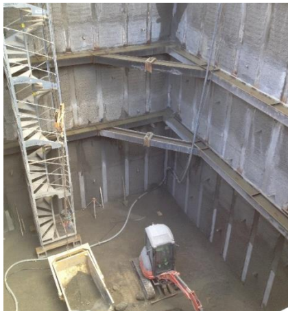
Berlinoise du puits d'attaque
