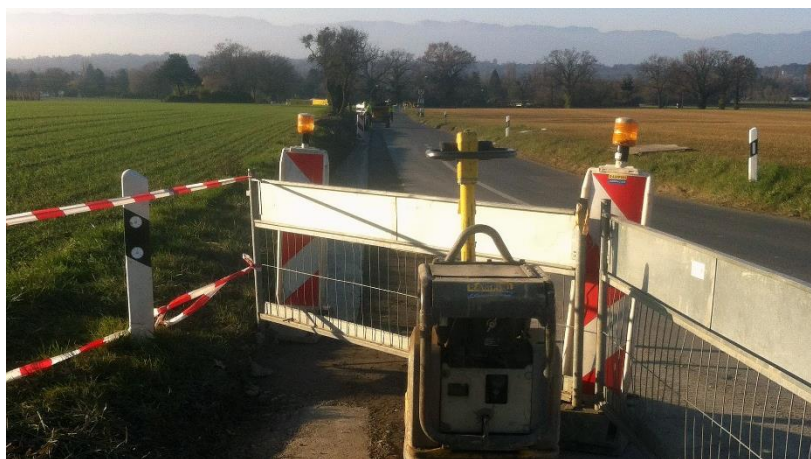
Remblayage de la fouille
