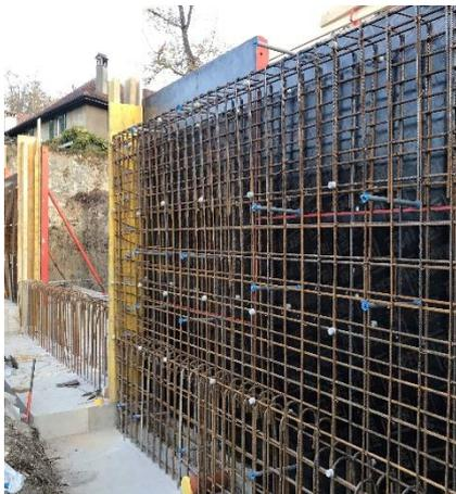
Coffrage et ferrailage du mur
