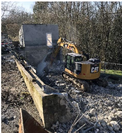
Démolition de la STEP
