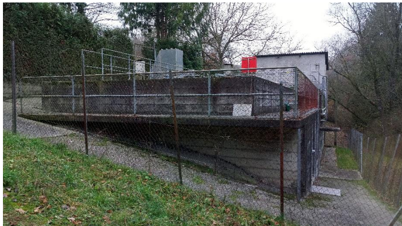
STEP avant la démolition
