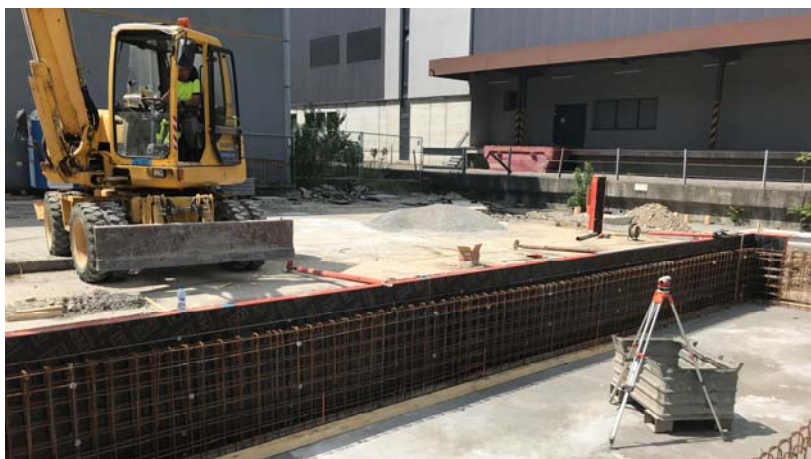
Construction de la fosse
