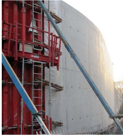
Pendant les travaux
