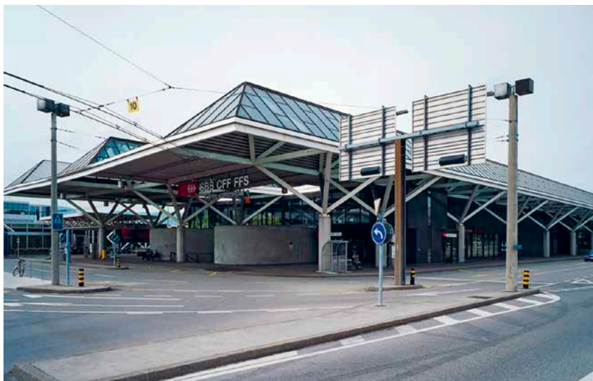
Gare CFF Genève-Aéroport, CH-1215 Genève 15 Aéroport, 1983
