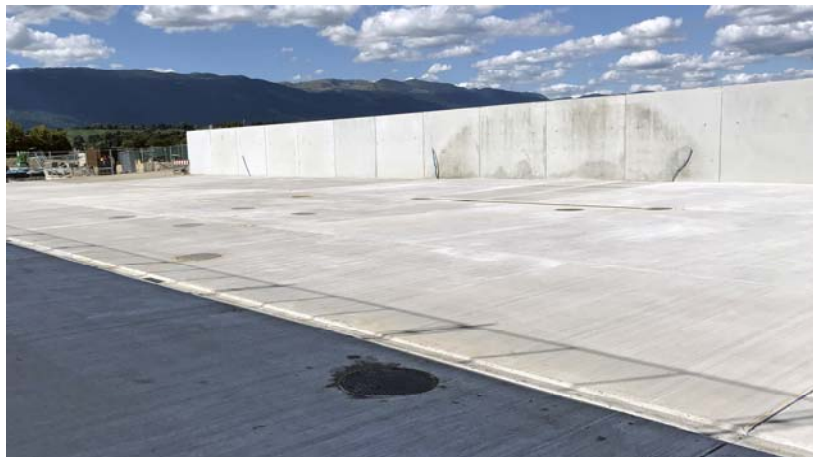
Dallage et mur d'enceinte de la nouvelle cour extérieure
