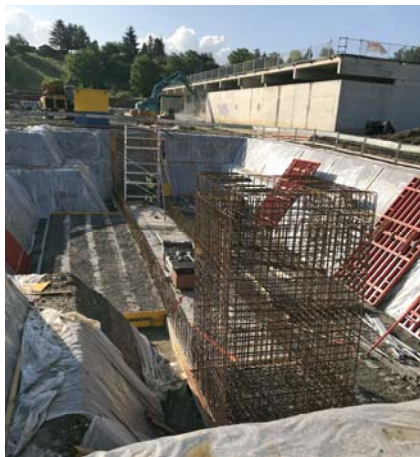
Fondation de la station-service
