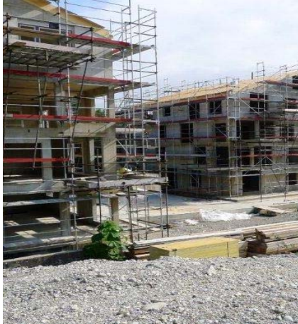
Pendant les travaux
