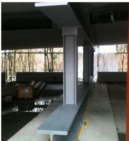
Travaux en cours
