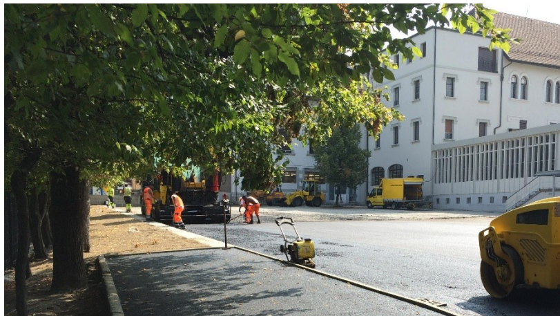
Pose des enrobés
