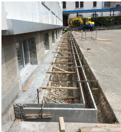
Construction de murets
