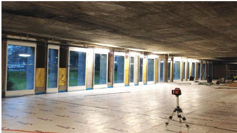
Ouvertures réalisées par sciage
