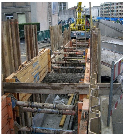
Travaux de collecteurs
