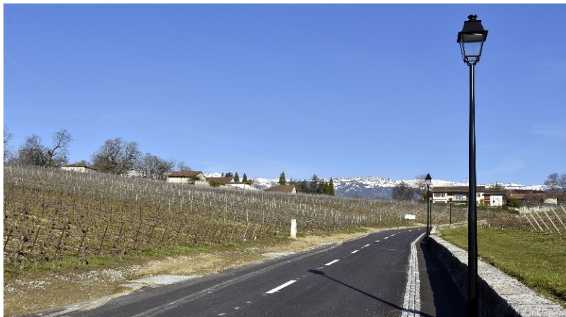
Rampe de Chouilly après les travaux
