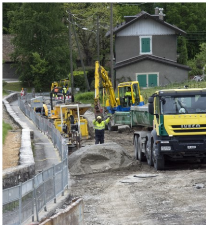
Réalisation de l'encaissement de la chaussée
