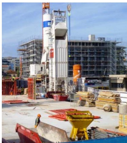
Pendant les travaux
