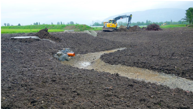
Bassin de rétention avec trop-plein
