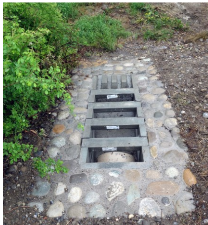
Extrémité du trop-plein
