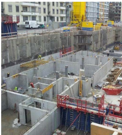
Pendant les travaux
