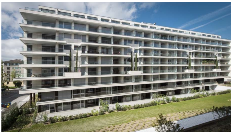
Après les travaux
