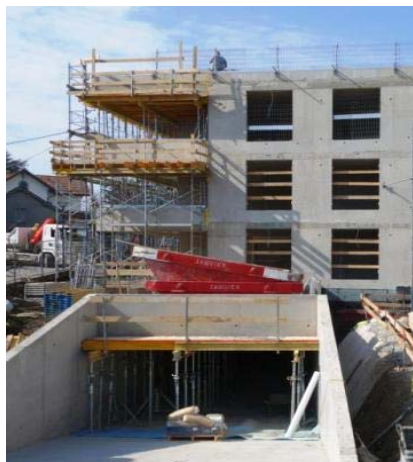
Pendant les travaux
