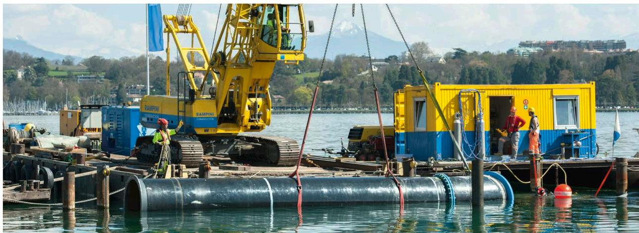
Les Services Industriels de Genève ont lancé la première phase des travaux du projet GeniLac. A terme, un réseau de distribution de l'eau du lac Léman permettra le refroidissement et le chauffage des bâtiments du centre-ville de Genève.
