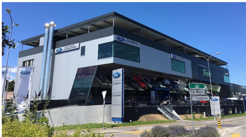
Bâtiment terminé en activité
