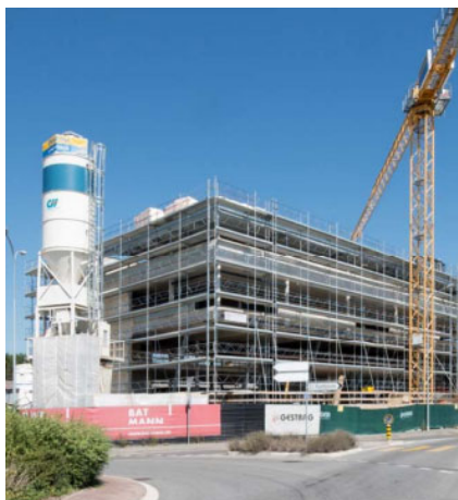
Installation du gros œuvre
