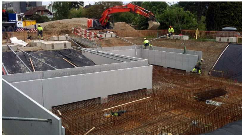
Pose des pré-murs
