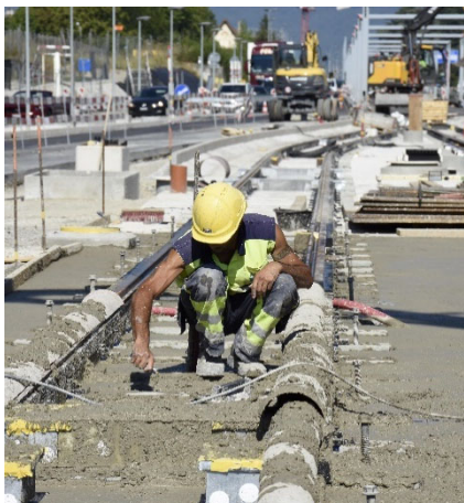
Bétonnage des voies de tram
