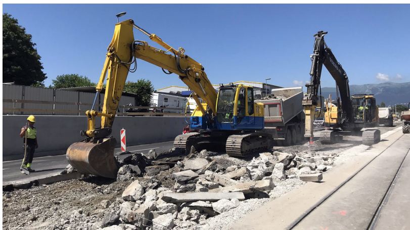
Démolition des voies de tram existantes
