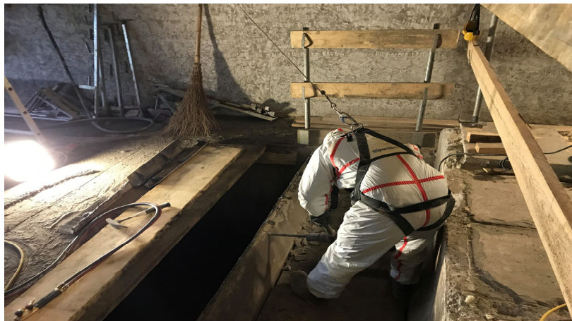
Démolition du déflecteur sur canal en service
