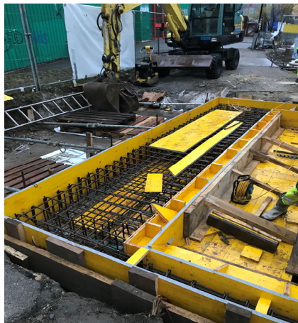
Coffrage et ferrailage de la dalle de la trappe
