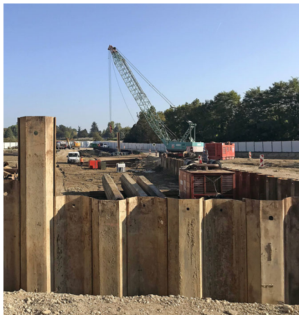
Battage des palplanches
