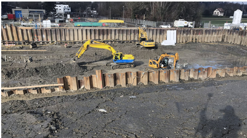
Terrassement en pleine masse
