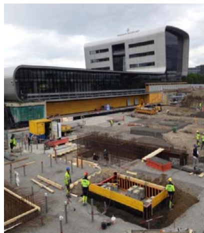
Pendant les travaux
