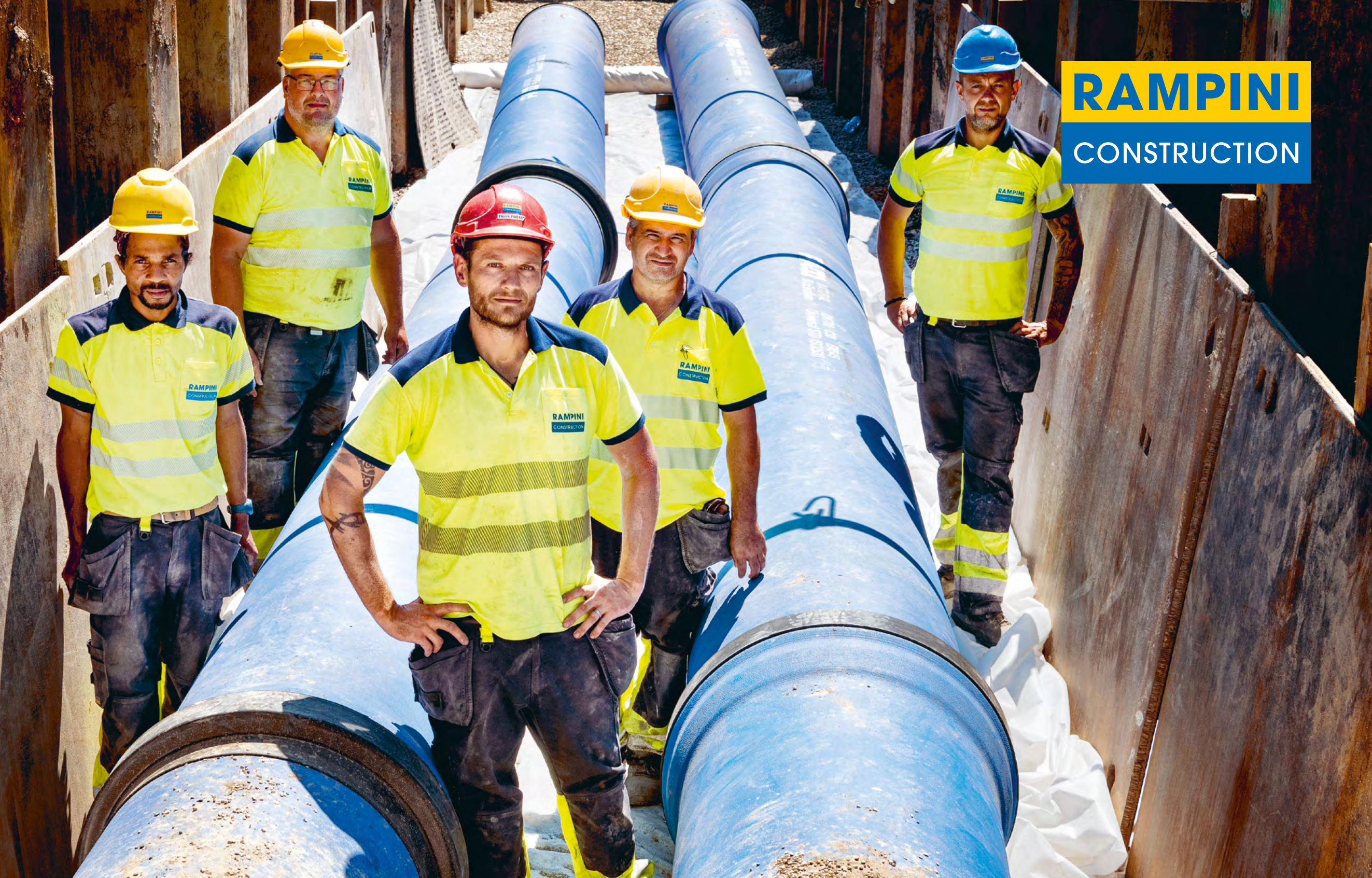
Projet d'aquathermie EnerLac: pose des conduites de chauffage à distance, Tolochenaz - CH-1110 Morges - Photo: François SCHAER 2021
