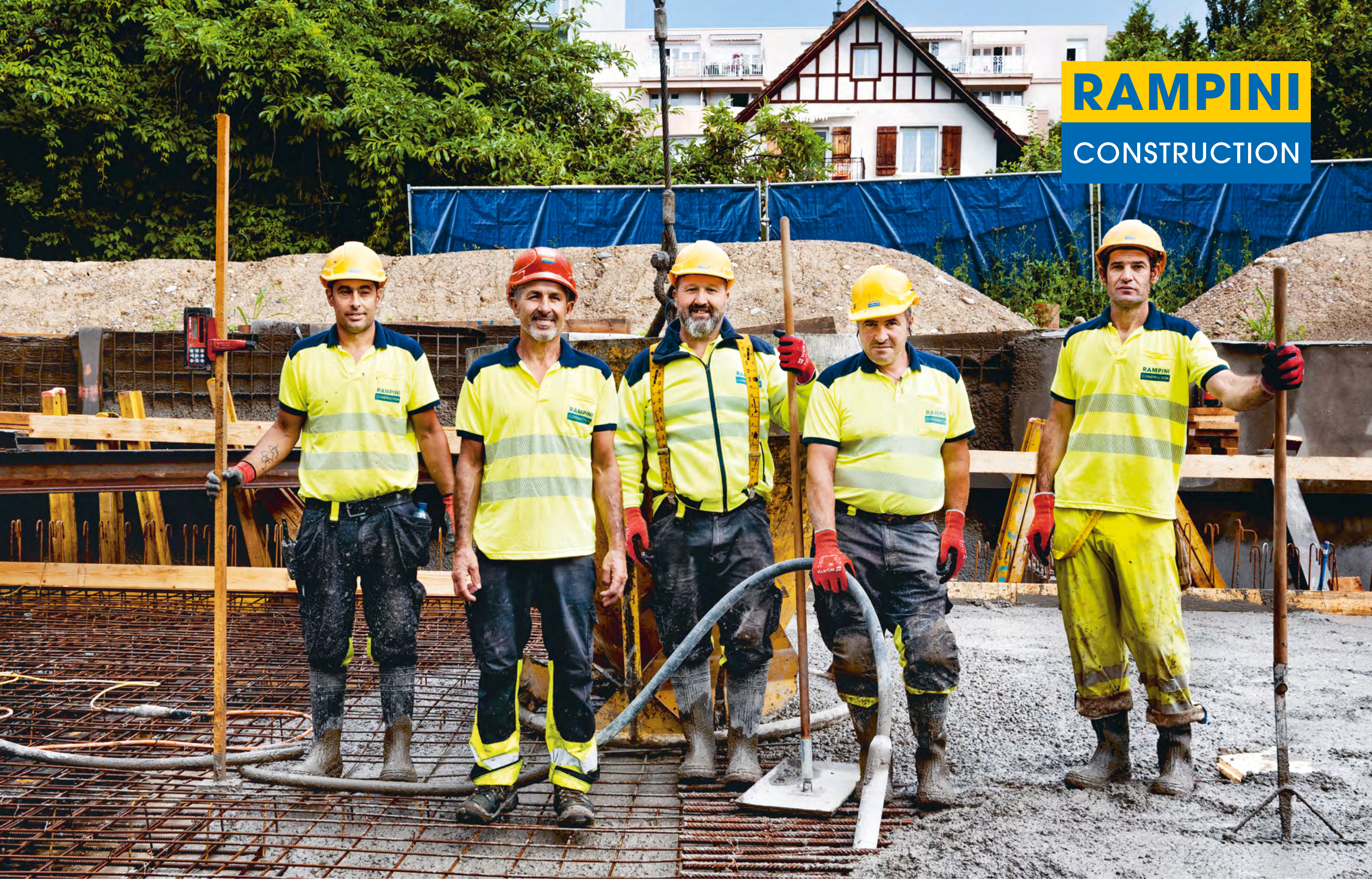
Réalisation d'un immeuble de logements dans le quartier du Mervelet, Avenue de Riant-Parc 5 - CH-1209 Genève - Photo: François SCHÄER 2021
