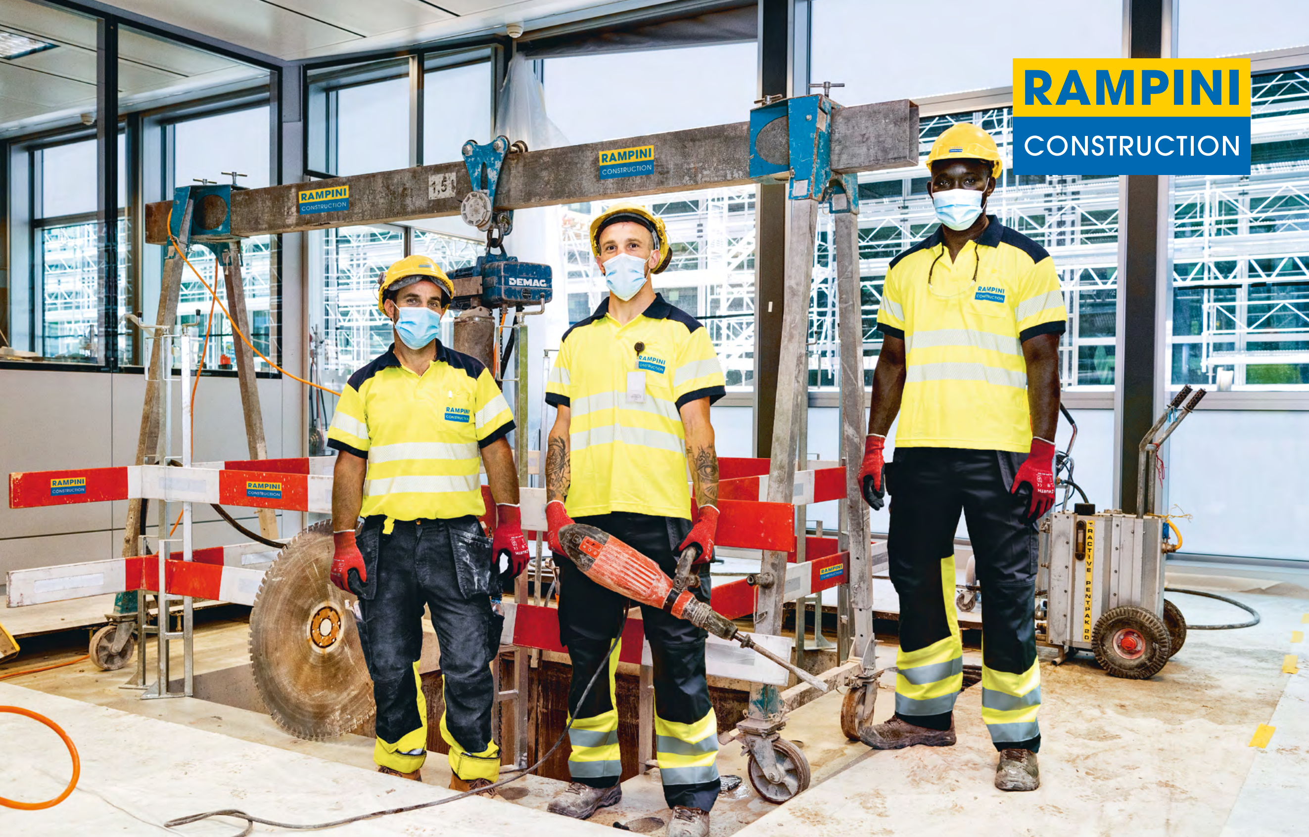
Travaux de démolition par sciage et carottage avec bâtiment en activité, CH-1205 Genève - Photo: François SCHAEER 2021
