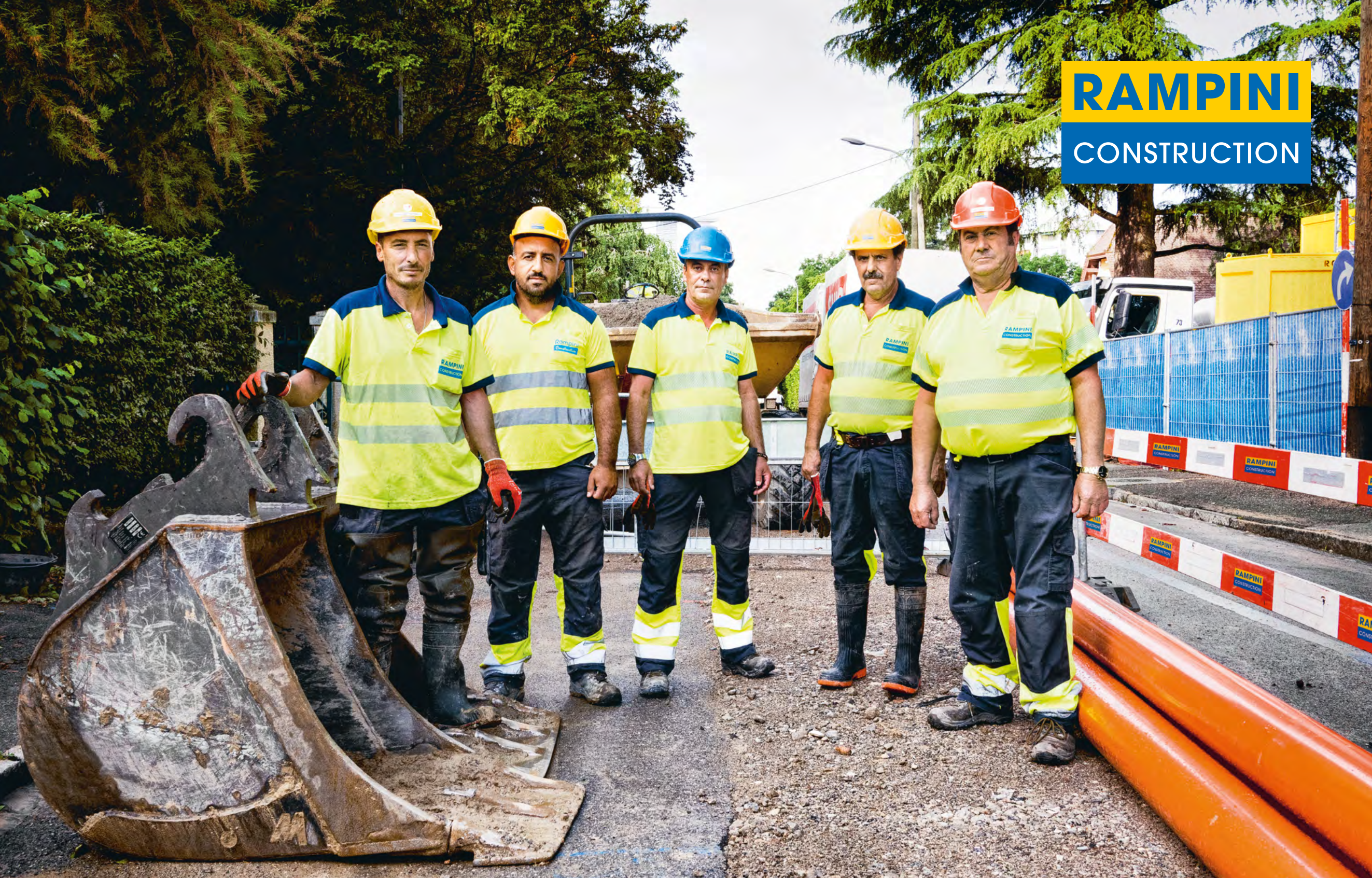
Réalisation de collecteurs eaux usées et eaux claires et aménagements de surfaces, Quartier du Mervelet - CH-1209 Genève - Photo: François SCHAER 2021
