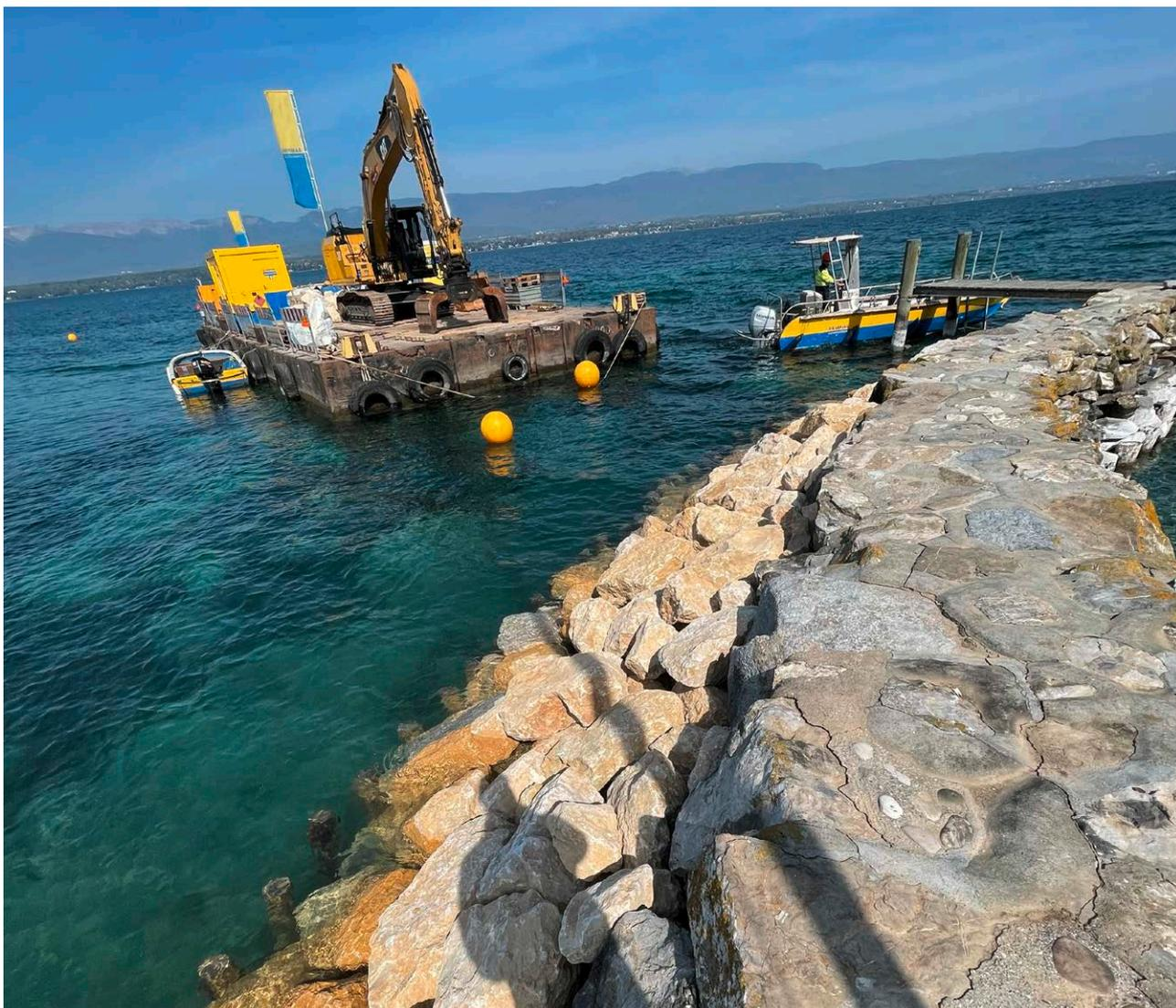
Au sein d'une magnifique propriété bénéficiant d'un port privé de grande envergure, la digue de protection se détériore au fil du temps sous les sollicitations combinées du vent et la houle.
