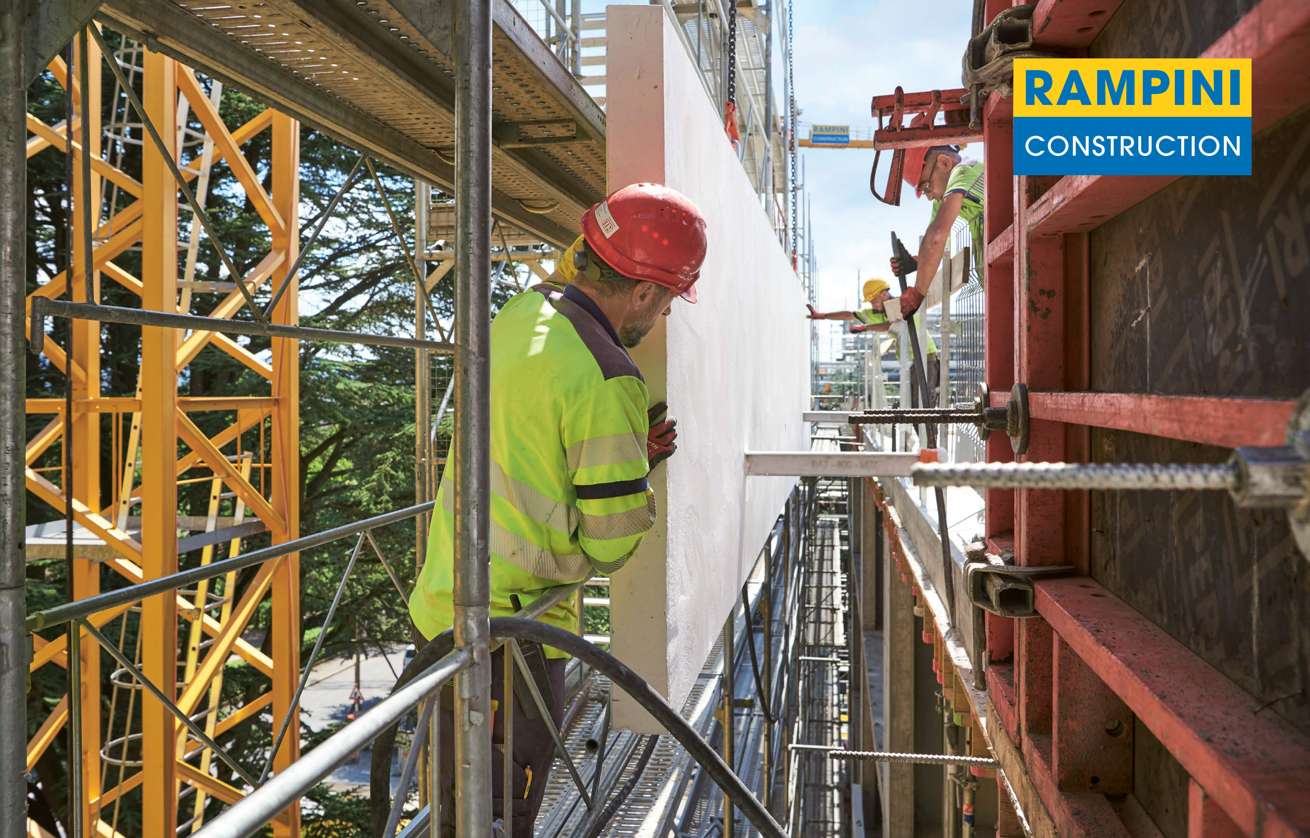
Construction de quatre immeubles composés de 62 logements, Avenue de Riant-Parc 9, 15 - CH-1209 Genève - Photo: François SCHAER 2022
