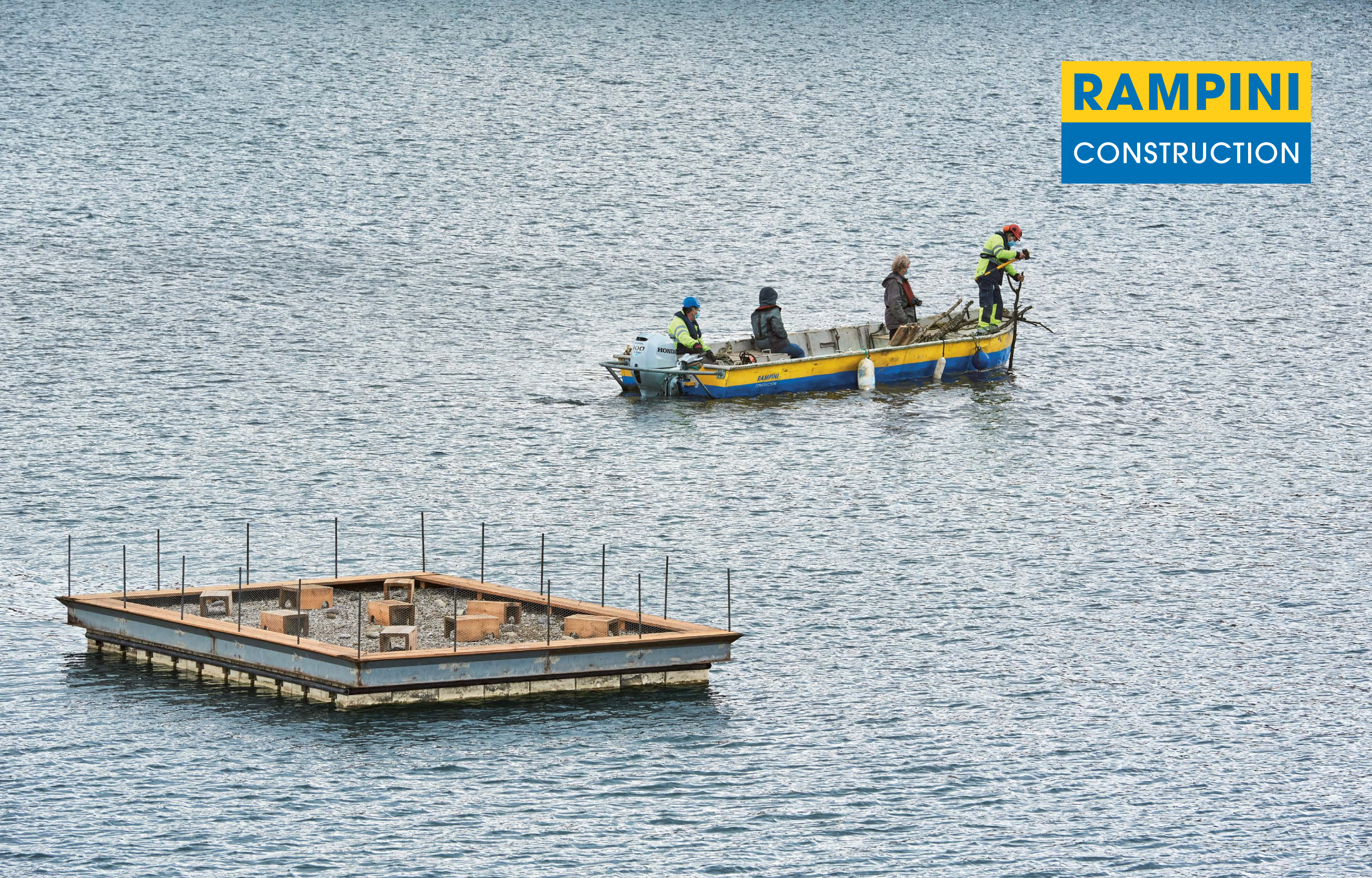
Remise en place de radeaux à sternes, Verbols - CH-1288 Aire-la-Ville - Photo : François SCHAER 2022
