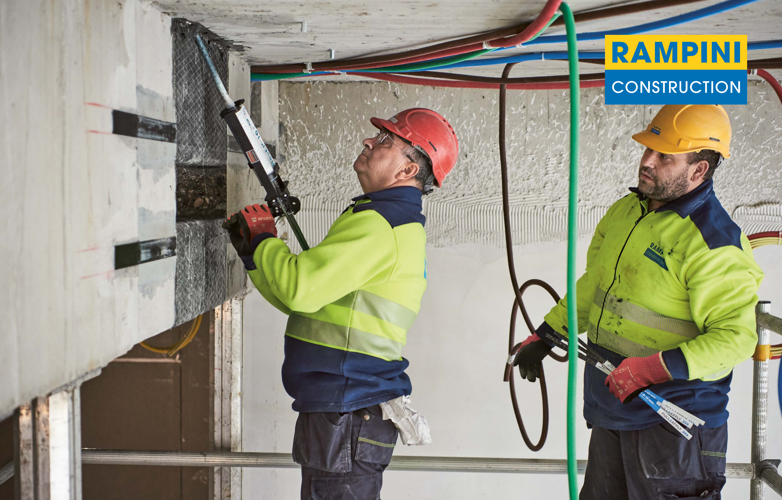
Réhabilitation et transformation d'un groupe de bâtiments techniques et administratifs, Rue de Veyrot 39 - CH-1217 Meyrin - Photo: François SCHAER 2022
