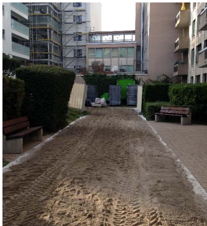
Pendant les travaux
