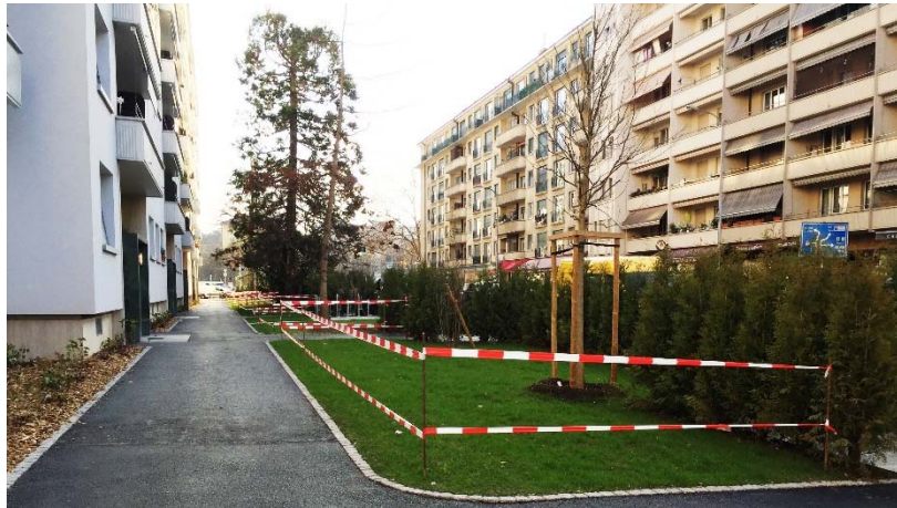
Après les travaux
