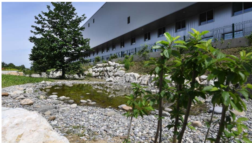
Après les travaux
