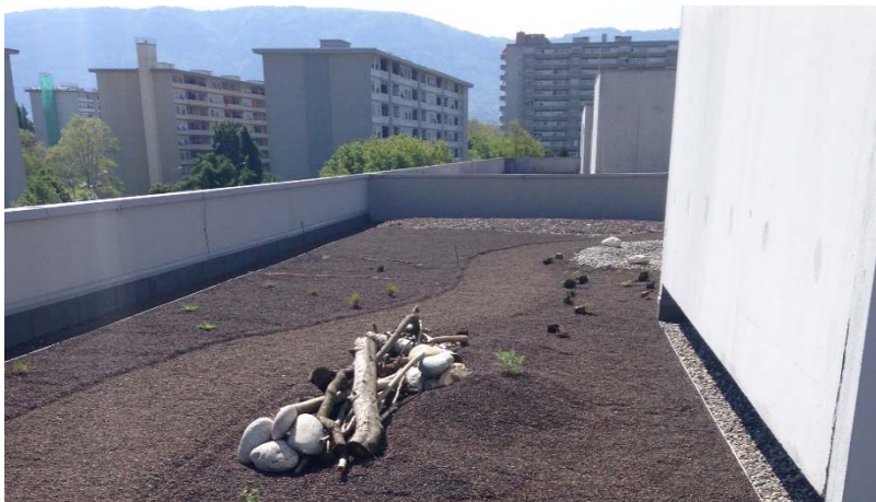
Après les travaux
