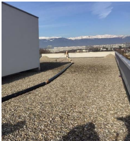
Pendant les travaux
