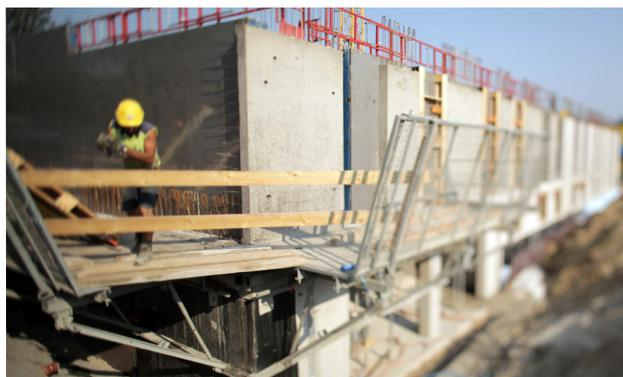
Nous avons réalisé l'ensemble de la maçonnerie et la mise en place de 2'800 m<sup>3</sup> de béton, fournis par notre centrale foraine. Les 6'000 m<sup>2</sup> de coffrage de murs et les 5'700 m<sup>2</sup> de coffrage de dalles ont été réalisés avec notre matériel, Hussor et Topec.
