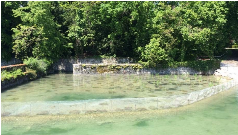
Après les travaux
