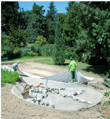
Pendant les travaux
