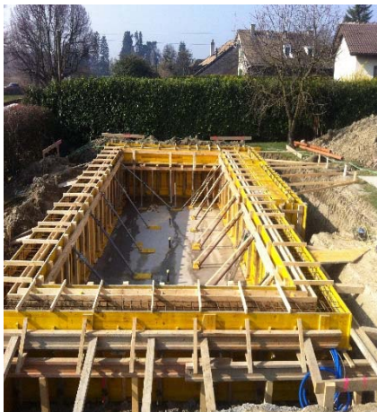
Pendant les travaux
