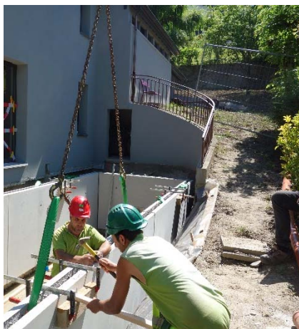
Pendant les travaux
