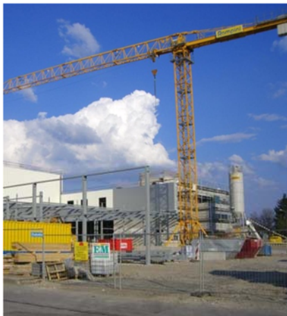
Pendant les travaux
