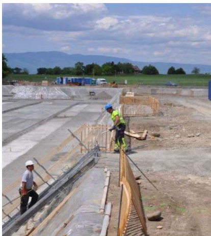
Pendant les travaux
