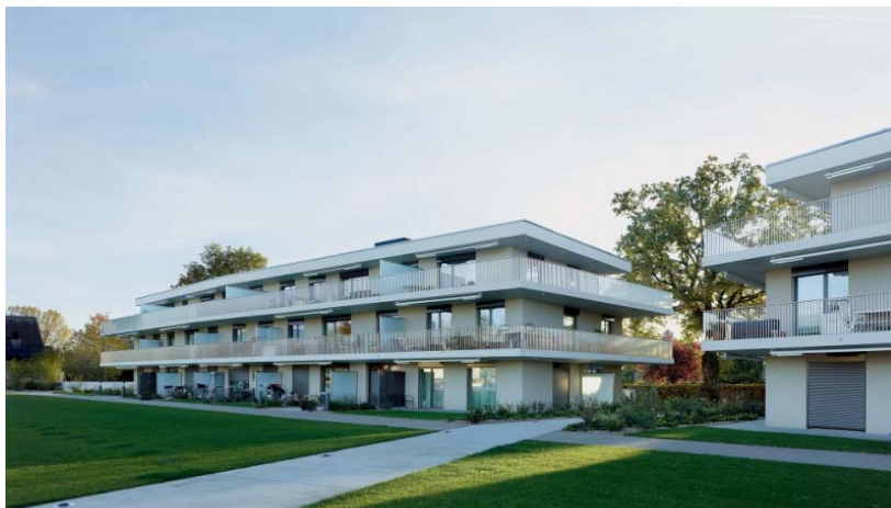
Après les travaux
