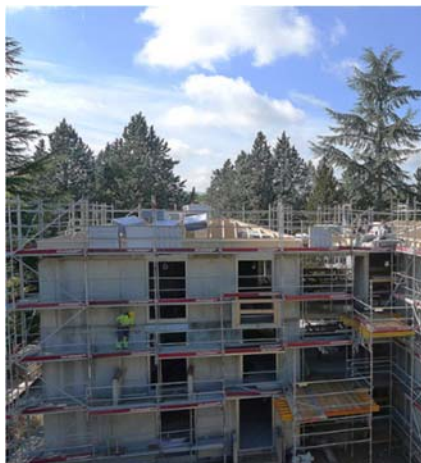
Pendant les travaux
