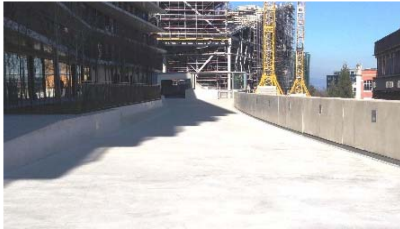
Après les travaux
